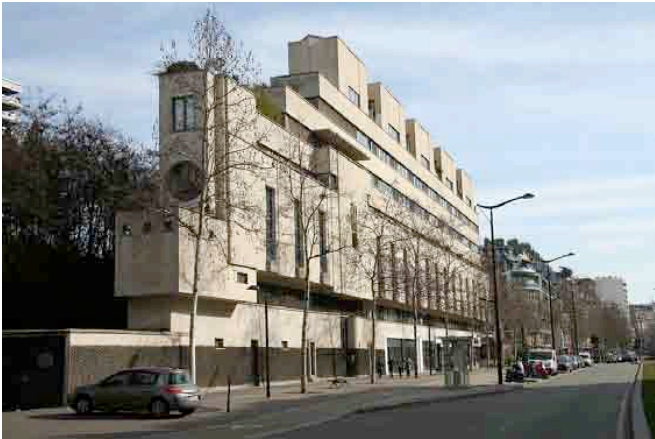
Pierre Patout's Immeuble Paquebot
